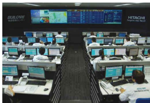
24時間365日昇降機を見守る日立カスタマーセンター
