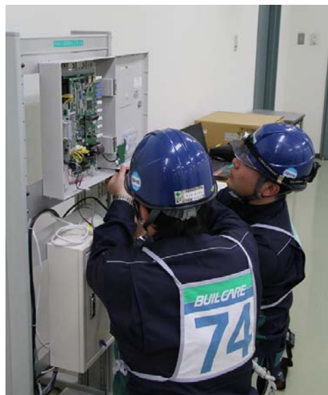
「BIVALE」コントローラー取り付け・設定作業
