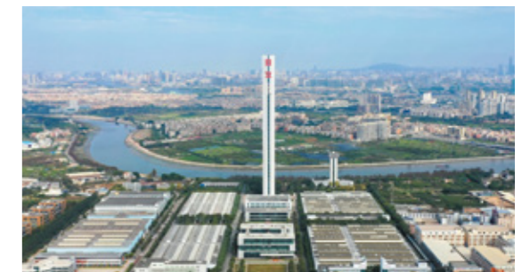
日立電梯(中国)大石工場
