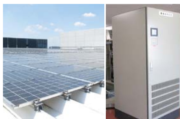
太陽光発電設備
