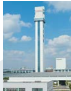
日立電梯(上海)エレベーター研究塔
