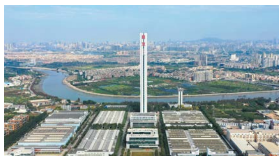
日立電梯(中国)大石工場
