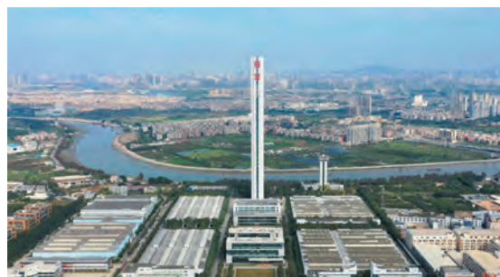
日立電梯(中国)大石工場
