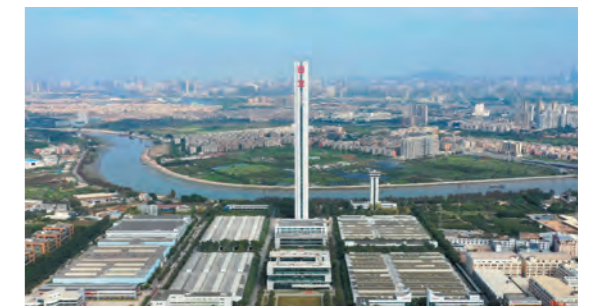
日立電梯(中国)大石工場
