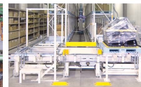
パレット自動倉庫
