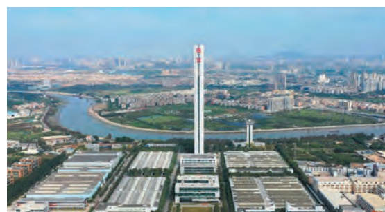
日立電梯(中国) 大石工場
