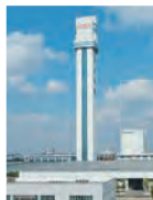
日立電梯(上海) エレベーター研究塔
