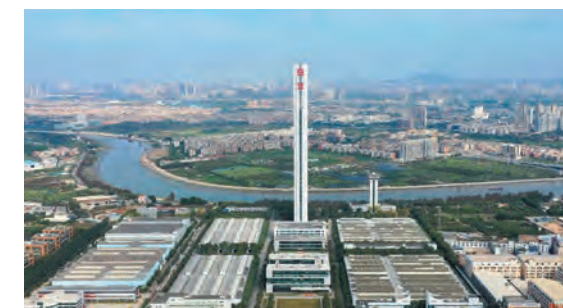
日立電梯 (中国) 大石工場
