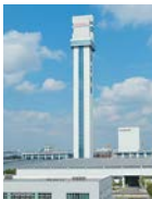
日立電梯(上海) エレベーター研究塔
