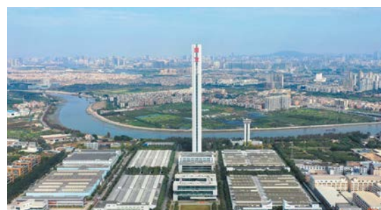
日立電梯(中国)大石工場
