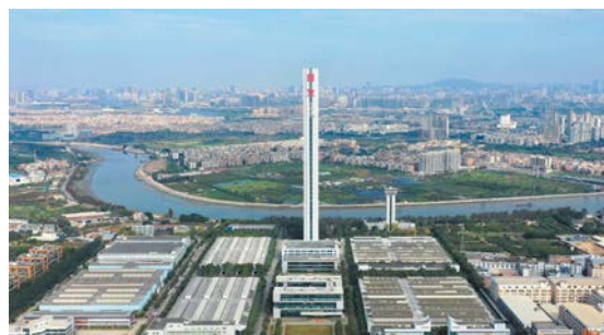
日立電梯(中国)大石工場
