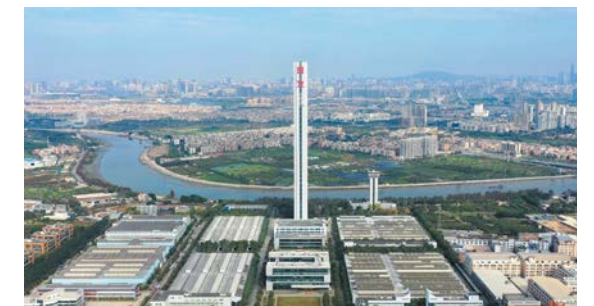
日立電梯(中国)大石工場
