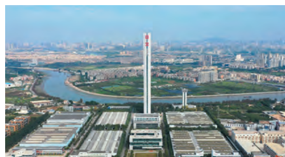
日立電梯(中国)大石工場
