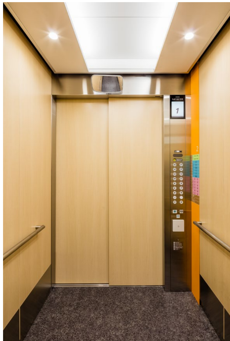
福祉施設側 エレベーターかご内
